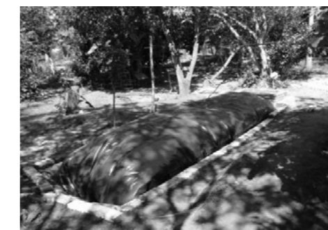
Figura 1. Biodigestor instalado en una de las 20 fincas de las familias beneficiadas.
