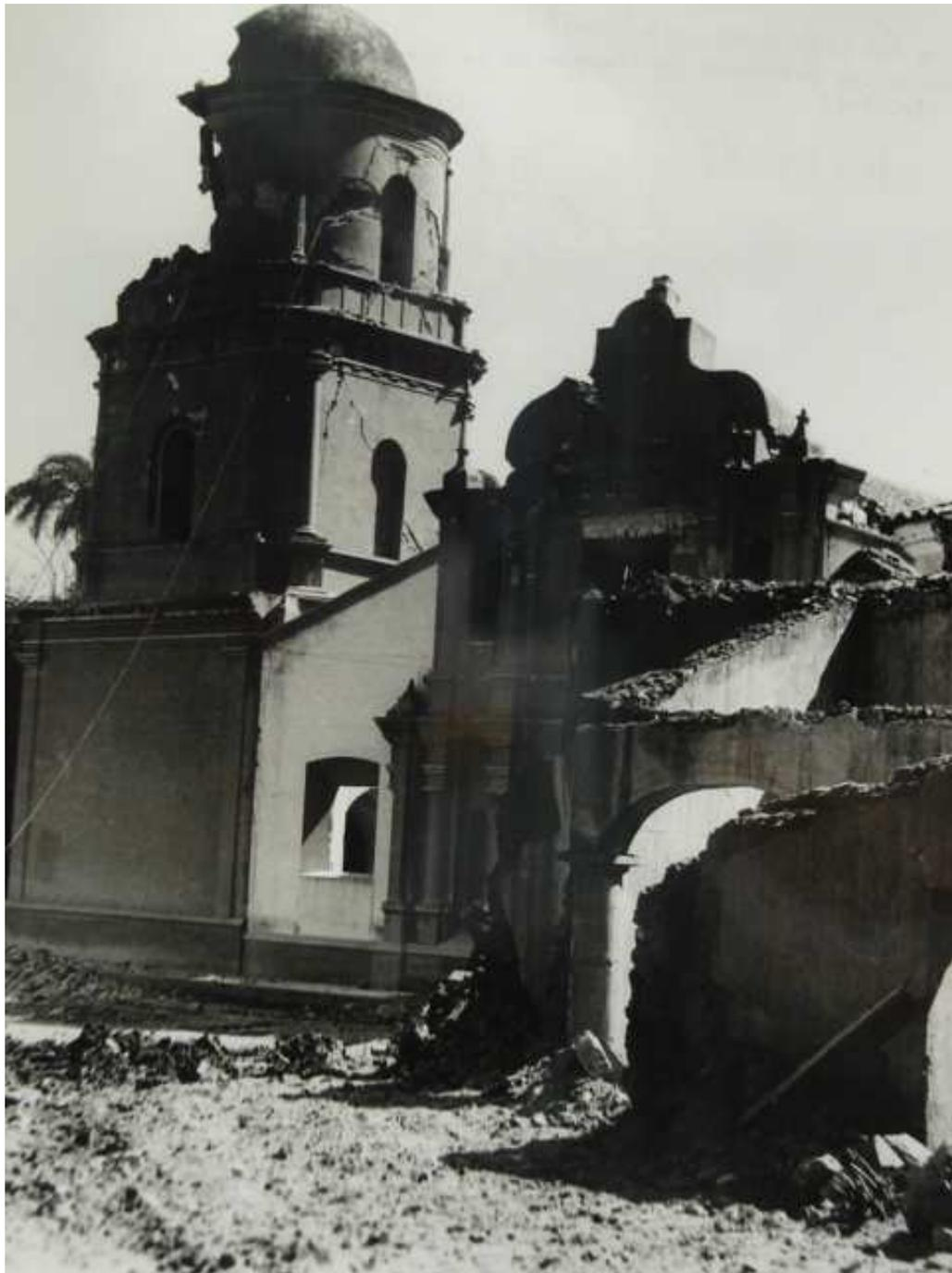
Figura 8.- Trabajos de demolición de las ruinas de La Concepción.<sup>513</sup>
