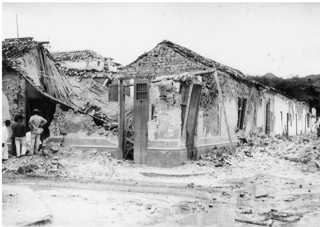
Figura 20. Vivienda parcialmente colapsada en El Tocuyo.<sup>705</sup>
