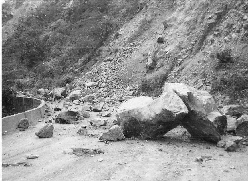
Figura 3. Derrumbes en la carretera hacia Guarico, sector Las Adjuntas.<sup>487</sup>
